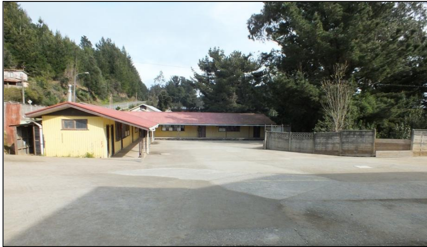
Figura 6. Instalaciones de la Escuela Rayén Lafquén que se emplazan sobre relleno artificial.
