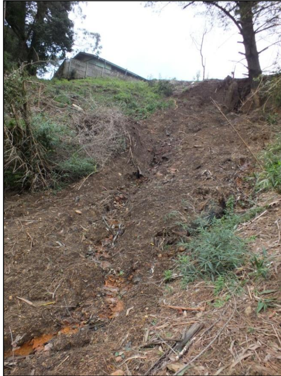
Figura 11. Bajo el punto B se observa vertiente de agua que filtra a través del terreno.
