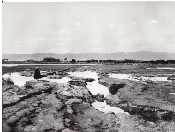
Fotografía 48. Grietas producidas por el terremoto. Material facilitado por Sra. Hilma Munro
