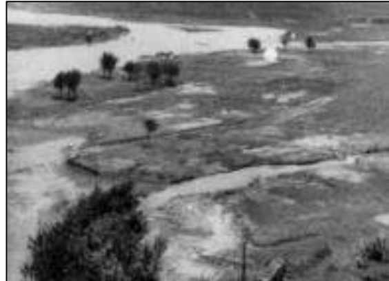
Queule después del Terremoto (1960)
